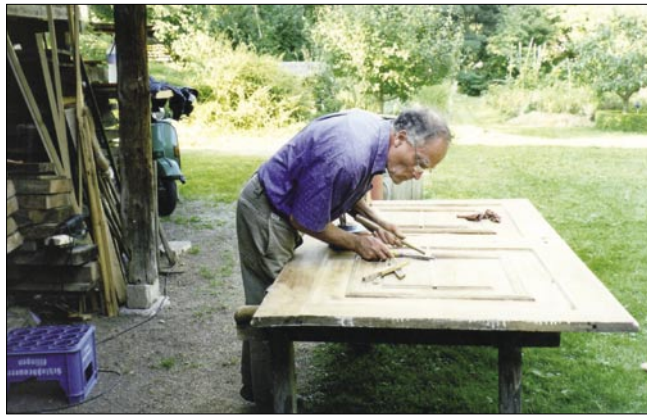
Alle Details wurden in liebevoller Handarbeit restauriert, um die einmalige Atmosphäre des Gebäudes wiederherzustellen.
